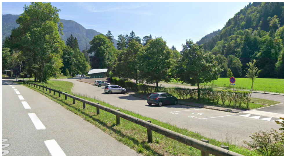
Parking de 45 places réalisé en 2023-2024
